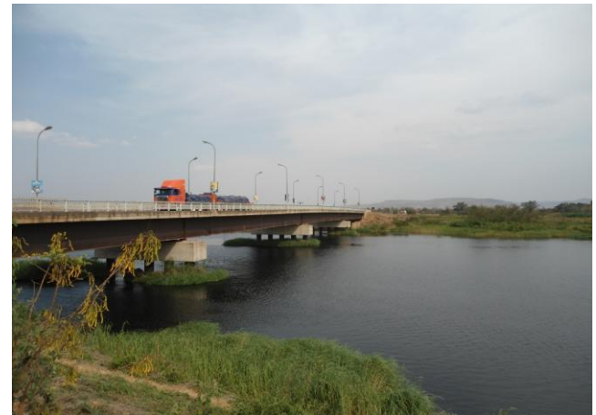
Kafue Road Bridge
